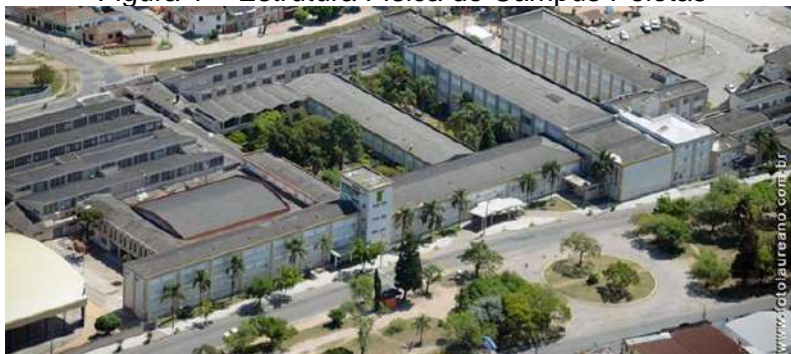
Figura 1 – Estrutura Física do Câmpus Pelotas
