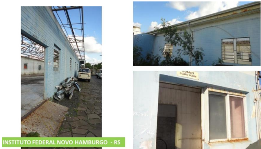
Figura 2 - Prédio recebido da prefeitura de Novo Hamburgo em 2014 para utilização como câmpus do IFSul
