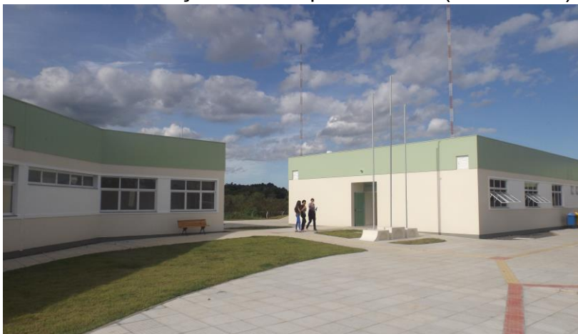
Figura 7 – Novas instalações do câmpus Gravataí (dois blocos)
