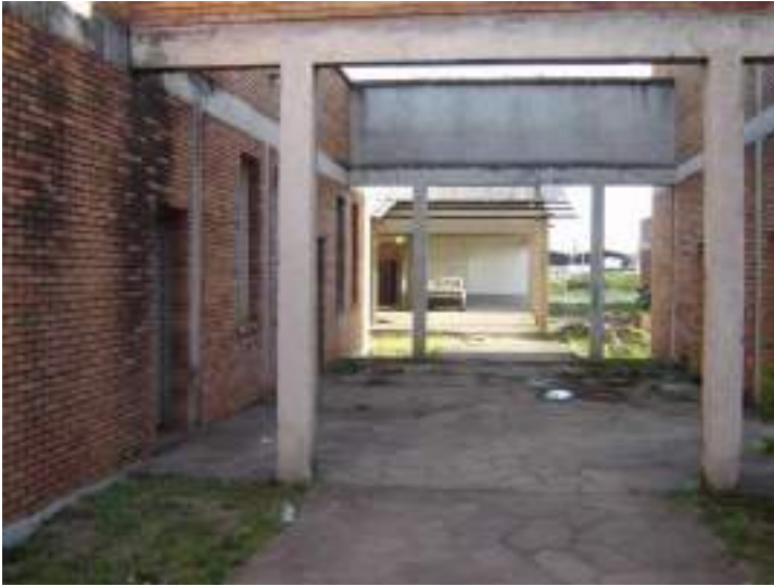
Figura 6 - Acesso aos prédios abandonados.
