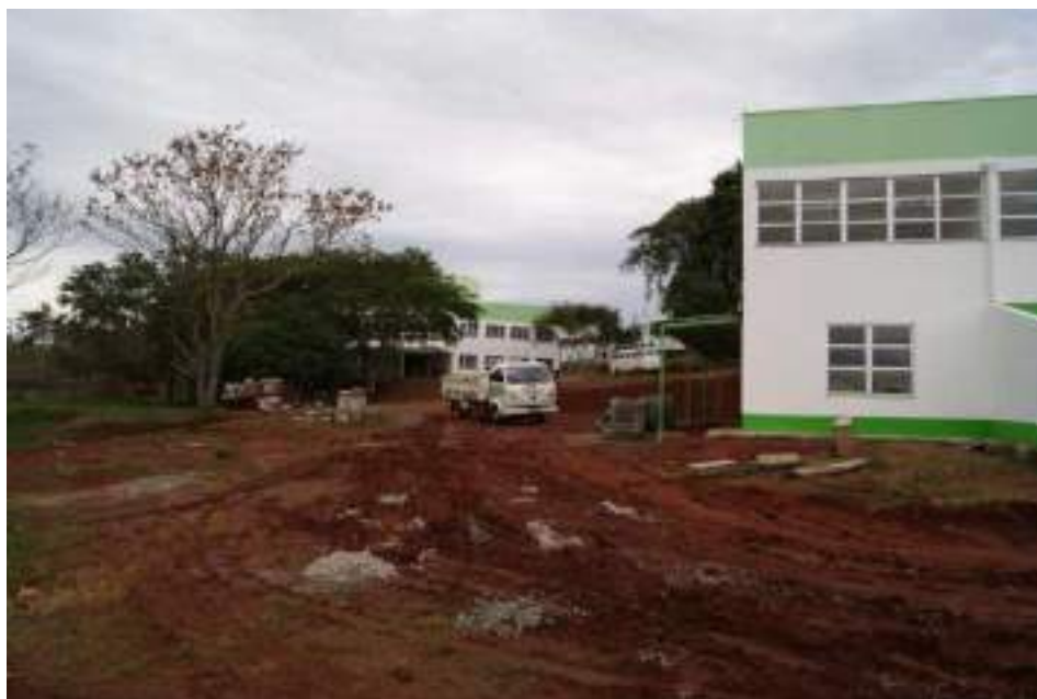
Figura 2 - Obras no Câmpus (2010)
