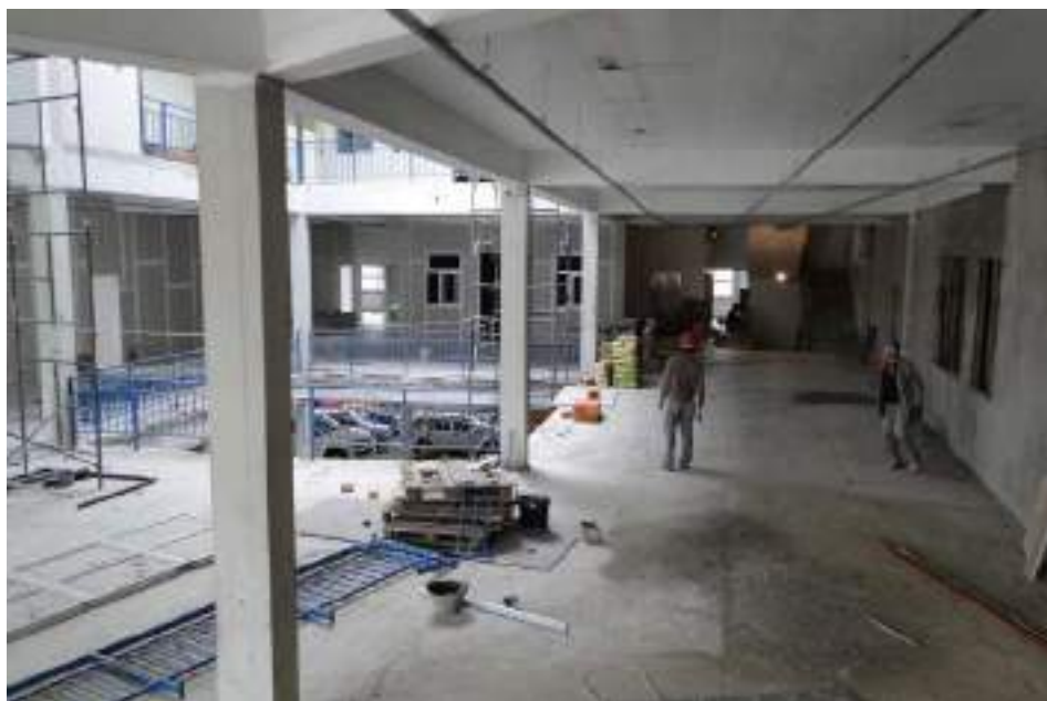
Figura 1 – Primeira obra do Câmpus Santana do Livramento (2012).
