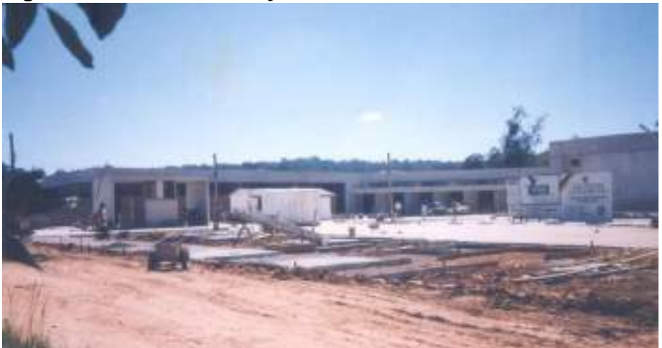
Figura 2 – 1995 – Construção da UNED
