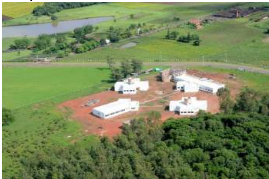
Figura 1 – Estrutura inicial do câmpus Venâncio Aires, em finalização.
