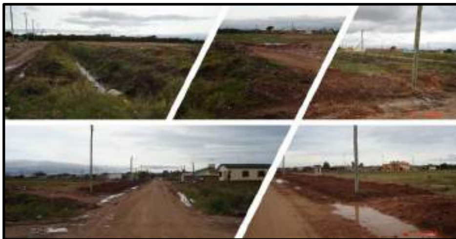
Figura 2 - Imagens do início da preparação do terreno (2008)
