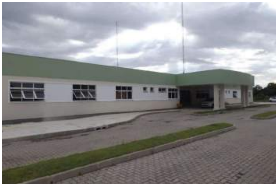
Figura 27 - Prédio multifuncional do Câmpus (janeiro de 2017)
