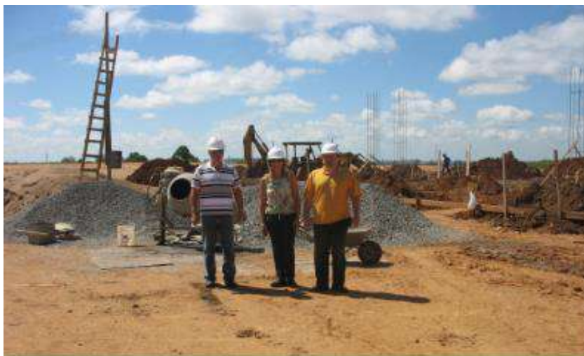
Figura 2 – Equipe diretiva do câmpus Bagé no canteiro de obras.
