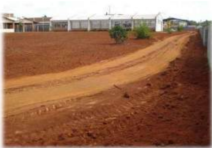
Figura 10 – Área em processo de reabilitação.
