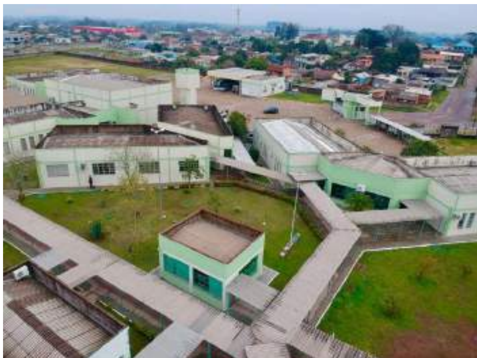
Figura 29 - Imagem aérea vista sul.
