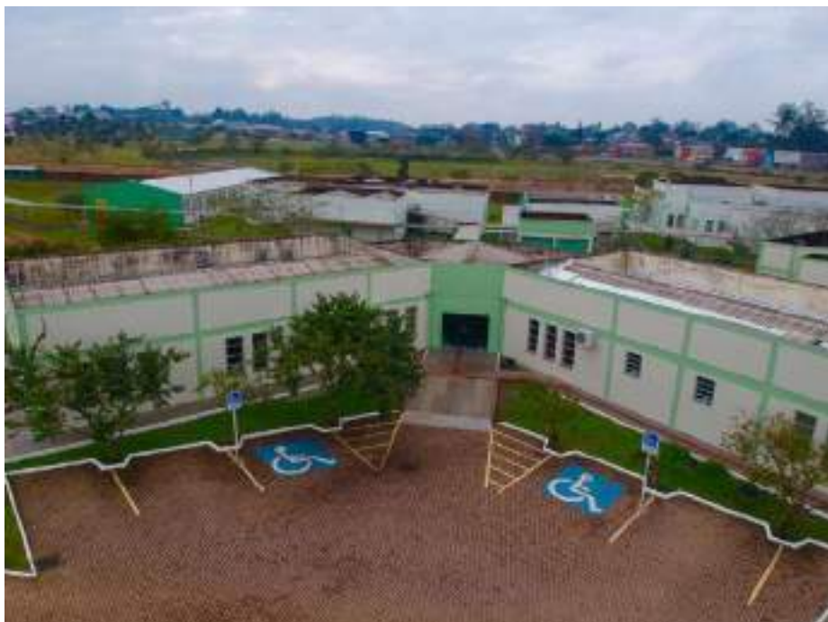
Figura 32 - Visão da acessibilidade e acesso ao prédio administrativo.
