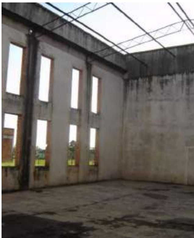
Figura 5 - Prédio abandonado onde hoje é o auditório.
